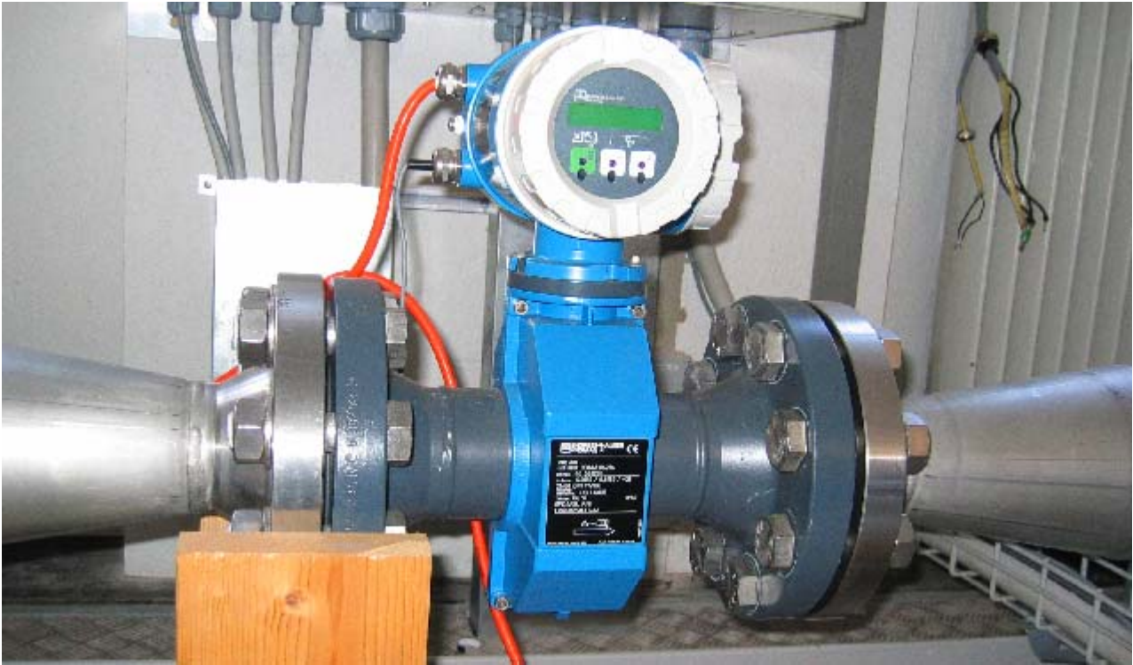
Abbildung 8 Beispiel eines eingebauten Durchflussmessgerätes
